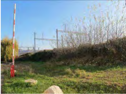
Talus des voies CFF (source : CSD)
