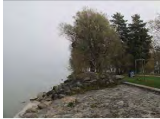
Enrochement à l'Est de la Plage (source : CSD)
