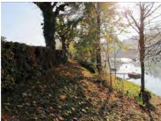
Berge de la Thièle à la hauteur du parking P + R de la gare (source : CSD)
