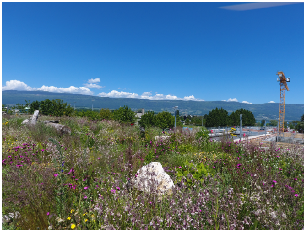
Figure 5 - Exemple de la toiture végétalisée de la STEP
